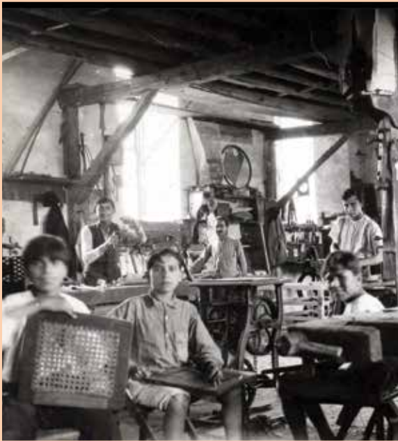
Okulun atölyesi, 1930 civarı.
